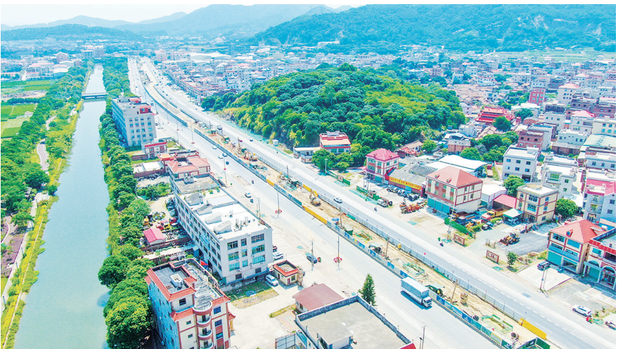
辅道实行半封闭模式,施工、通行两不误。 本报记者 陈逸帆 摄
